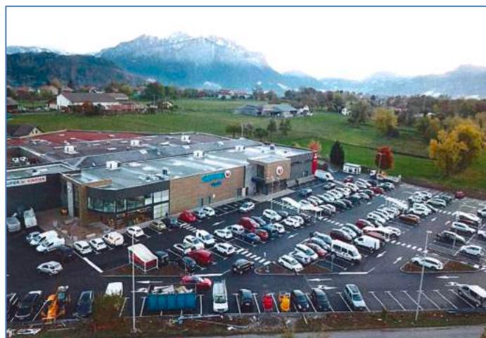
Vue générale du parking actuel.
