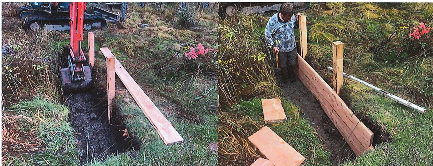
Figure 33 : exemple de réalisation de mise en place de batardeau sur des fossés en zone humide
