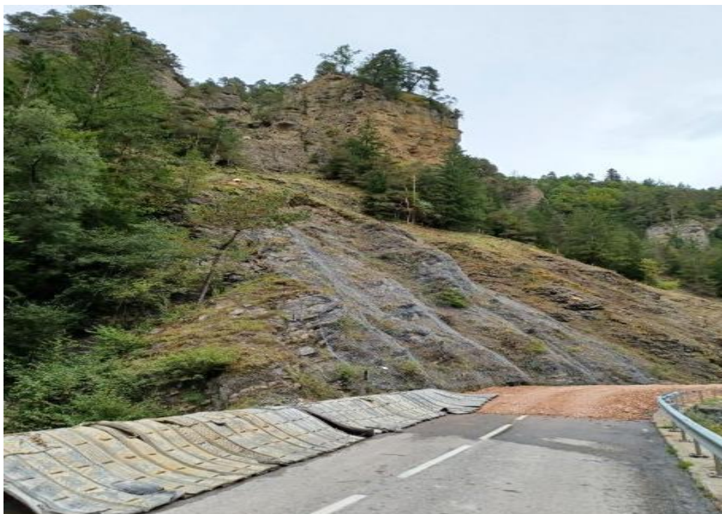
Travaux de protection des chutes de pierre SUR RD 22 par le Conseil Départemental
