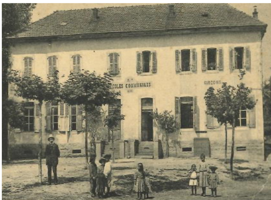
À Vinzier, le poids public était situé devant l'école, à droite sur la photo, sous les fenêtres
